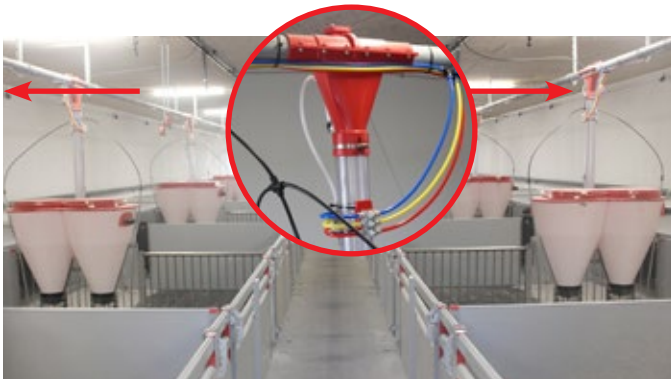
COLOR FEED SINGLE: Fasefodringsventil i smågrisestald
