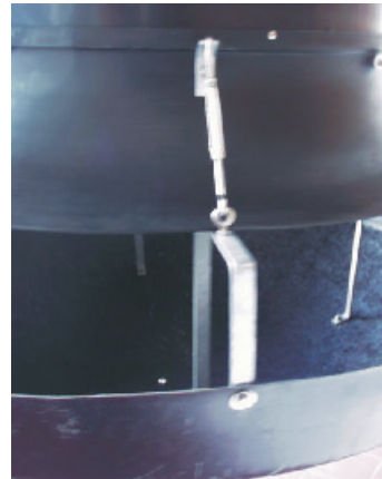
Beslag og bardunstrammer monteret på lysdæmper
