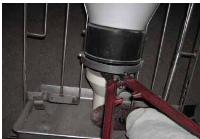
Er dette ikke muligt, frigøres hele klokken ved at klippe justerstangen over med en boltsaks, alternativt med en vinkelsliber.
