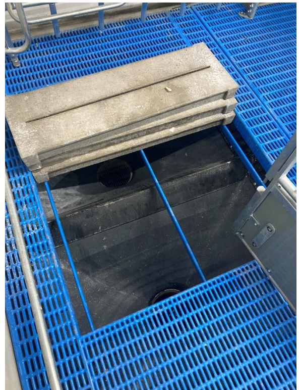
Figur 1 Øverst: overblik over stiindretning. Kvadratisk fulddrænet sti 2,6 m x 2,6 m. Nederst tv.: betonspalter der udgør det drænedegulv. Nederst th.: SpaceKit kassetter under gulv.
