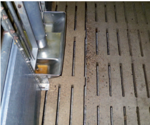
unbehandelt nach ca. 3 Jahren: Säurefraß im Boden
